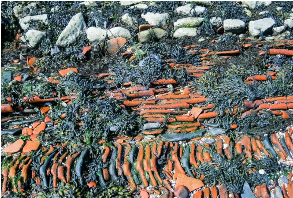
afb. 11. Dakpannen als dijkbekleding 2013.
