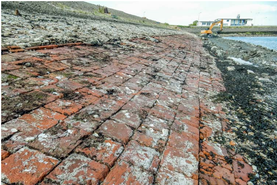
Afb. 15. Gebakken steen als dijkbekleding 2015.
