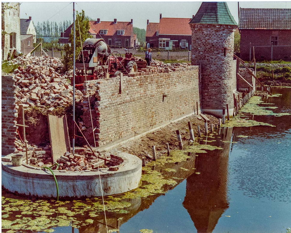
Een toren in aanbouw (l) met rechts een reeds voltooide toren.
