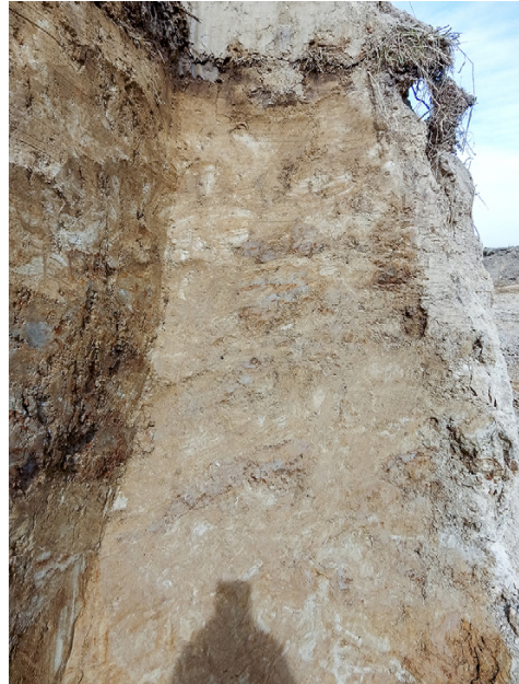
Afb.4. Ophogingslagen in het dijkprofiel van het zuidelijk “dijkhoofd”, locatie 1.
