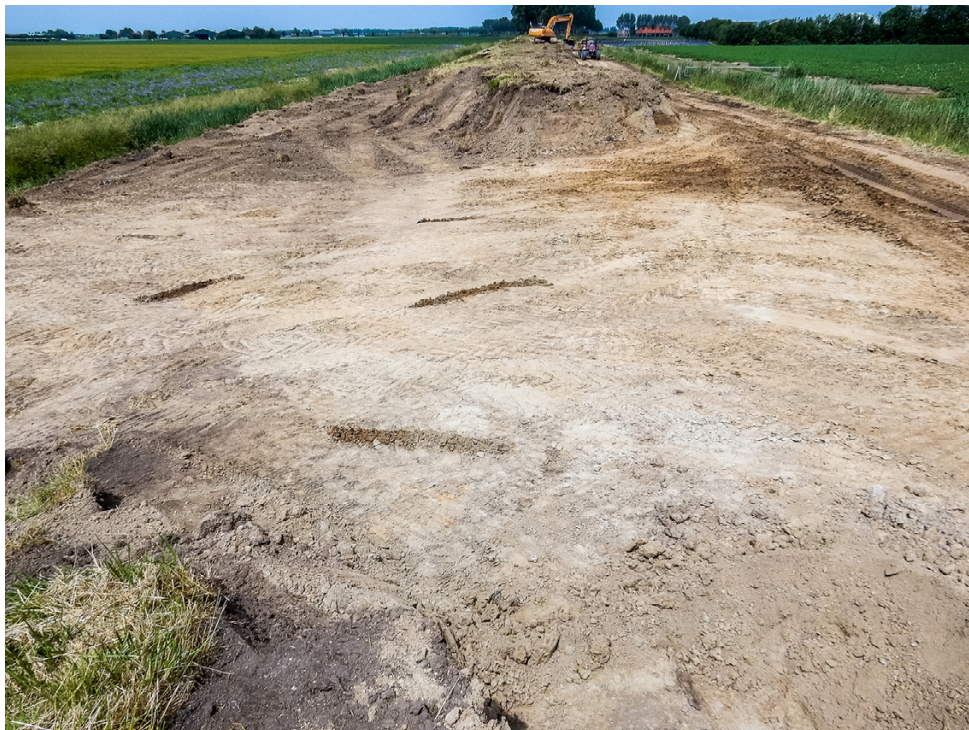
Afb.2. Doorgegraven Nieuwlandsedijk 18 juni 2019.
