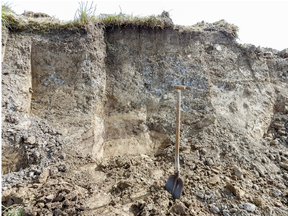
Afb.5. Ophogingslagen in het dijksprofiel van het noordelijk “dijkhoofd”, locatie 3.
