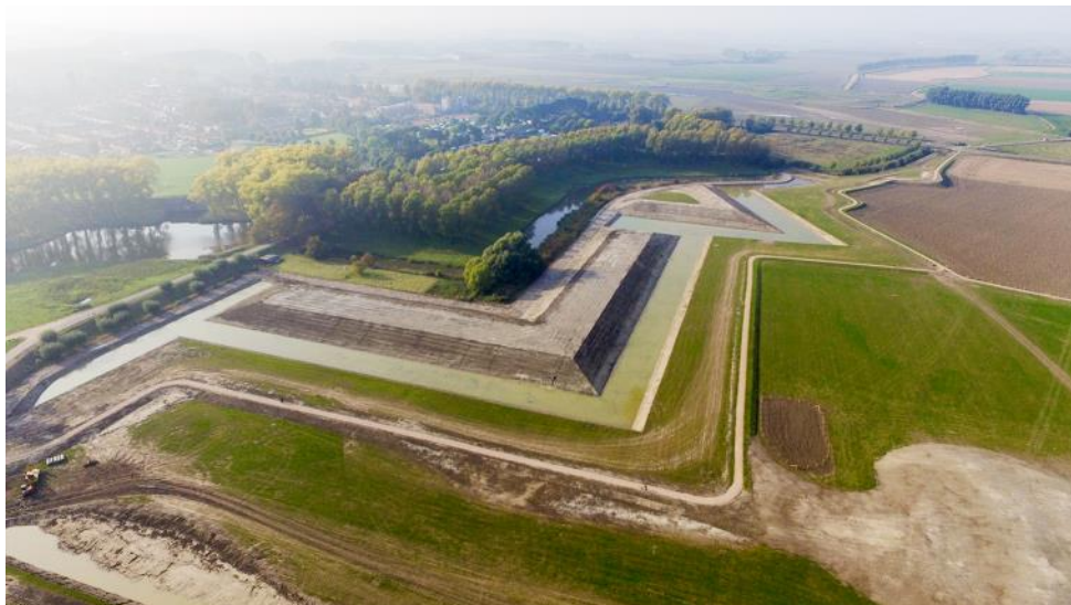
AFB33. Dronefoto van een nieuw aangelegde buitenwal van Sluis (Bron: Datafact).
