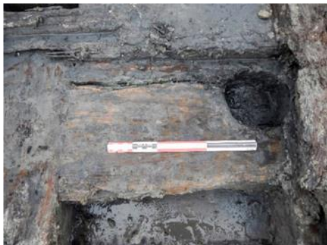
AFB28. Keuspot voor de as van de sluisdeuren (Bron: D'hondt 2019).
