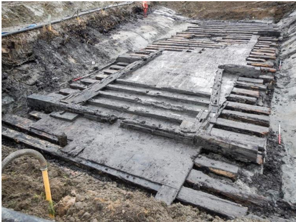
AFB27. Vloer van de Sluis (Bron: D'hondt 2019).
