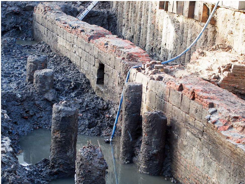
Bij het onderzoek onder het 's-Gravenhof kwam een muur tevoorschijn die bekleed was met natuursteen. Foto: Freddy van Puymbrouck.
