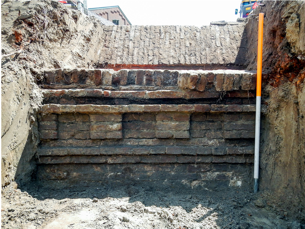
Muurwerk van het opgegraven Bastion Hollandia in Sas van Gent. Foto: Artefact.
